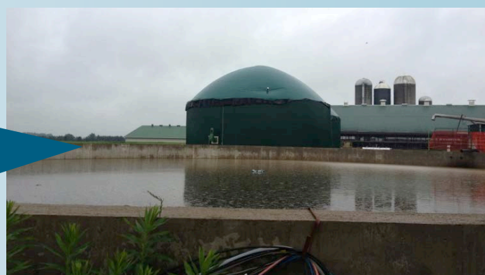
Digesteur anaérobie avec captage du méthane sous le dôme.
